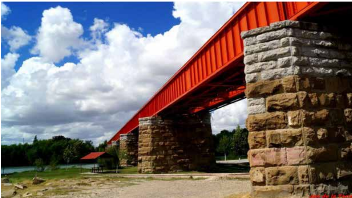
Figura 50. Puente “anaranjado” en Sabinas
